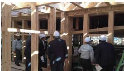
建設中の新庁舎を見学
